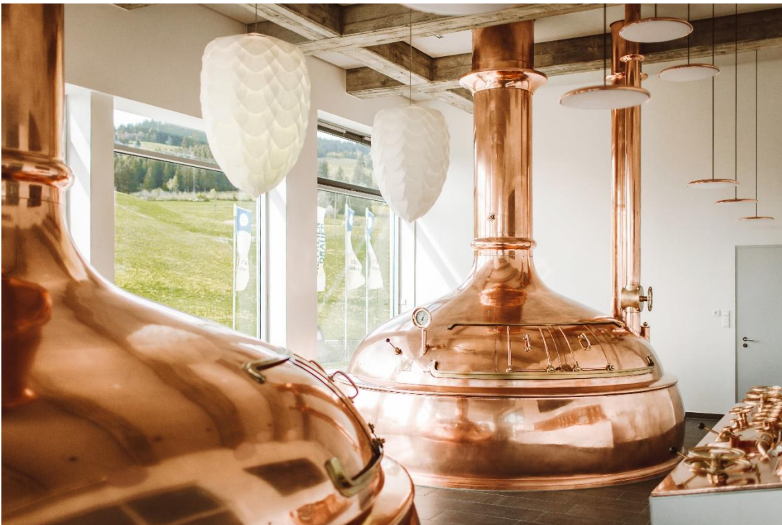
Abbildung 1: Innen hui, außen hui: Fast 60 Jahre hielt das alte Huppmann-Sudhaus, das Huppmann-Nachfolger GEA 2018 gänzlich unter der wunderschönen Kupferhaube erneuerte. Bild: Brauerei Zötler/Petra Reger
